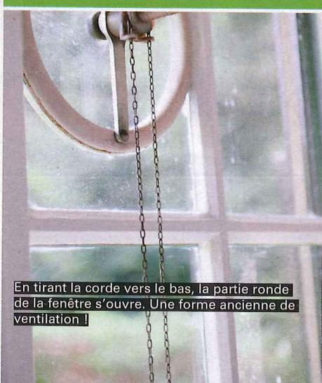
En tirant la corde vers le bas, la partie ronde de la fenêtre s'ouvre. Une forme ancienne de ventilation !
