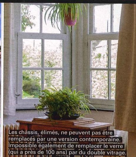
Les châssis, élimés, ne peuvent pas être remplacés par une version contemporaine. Impossible également de remplacer le verre (qui a près de 100 ans) par du double vitrage.
